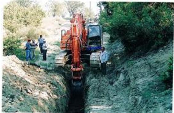
İş makinalarının halkın hizmetinde: En üstte Kestel Ovasında dere islah çalışması yapmakta. Yanda ve üstte Seydiköy - Bucak arasında yapılan içme suyu isale hattı kazı çalışmaları.
